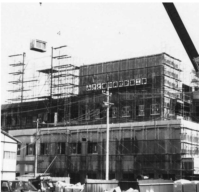
建設工事中の健和病院
